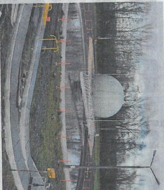
Komory osadu czynnego przed wypełnieniem ściekami
