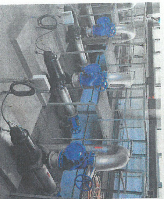
Fragment pompowni osadu nadmiernego i wtórnego
